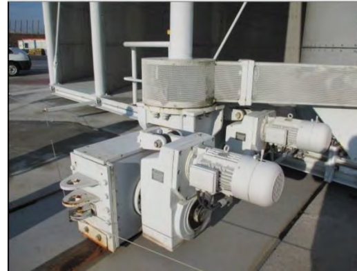
Äußeres Fahrwerk Tor 2
